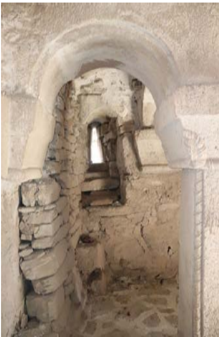
33. ფოტო: ჩუბინაშვილის ცენტრი, 2023 წელი, ტაძრის ინტერიერი, კედლების დაზიანებული არეები
