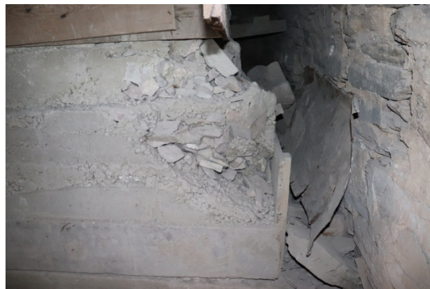
37. ფოტო: ჩუბინაშვილის ცენტრი, 2023 წელი, ტაძრის კონქის თავზე მოწყობილი რკინა-ბეტონის გამაგრების კონსტრუქცია
