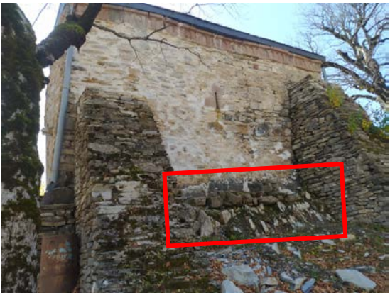
26. ფოტო: ჩუბინაშვილის ცენტრი, 2023 წელი, ჩრდილოეთი კედლის დაზიანებული არეები
