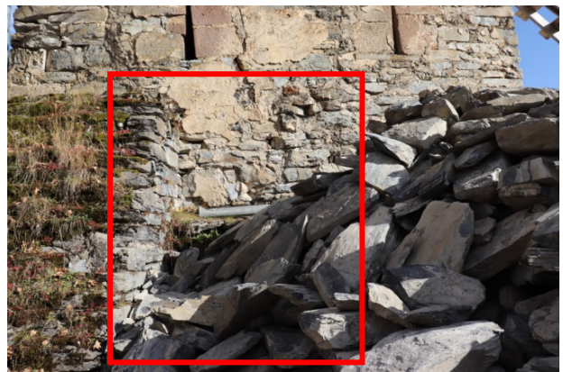
26. ფოტო: ჩუბინაშვილის ცენტრი, 2023 წელი, ჩრდილოეთი კედლის დაზიანებული არეები
